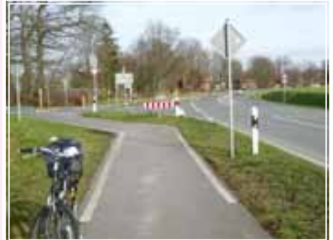
Bild 2: Einmündung L 843/ L 550, Tilbeck, Nähe Mordkreuz und Hexenpütt. Sperrbalken zeigt die frühere Führung.
