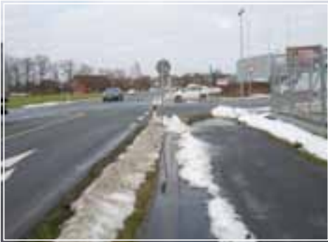
Bild 1: Einmündung Pienersallee/Nottulner Landstraße, Nähe Haltepunkt Münster-Roxel. Einseitigem Zweirichtungsrad-/Fußweg wurde die Vorfahrt genommen.
