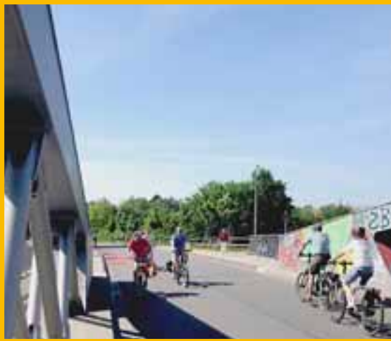
Brücken verbinden und sind ein wichtiger Baustein im Euregio-Fahrradkorridor
